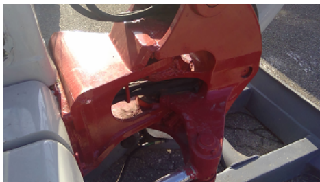
Observation 0302 : Défaut d'aspect FLECTE DEPORTE BLOQUE AVEC CALES SOUDEES AU CHASSIS FISSURES
