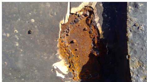
Observation 0302 : ROUILLE PERFORANTE SUR LAME STABILISATRICE
