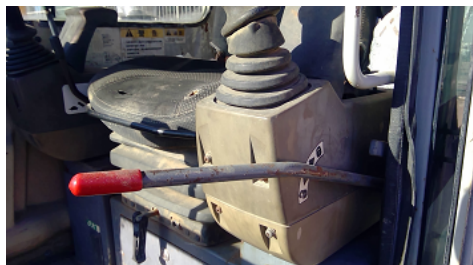
Observation 1003 : DYSFONCTIONNEMENT DE LA SECURITE ACCOUDOIRE NE TIENT PAS EN POSITION HAUTE
