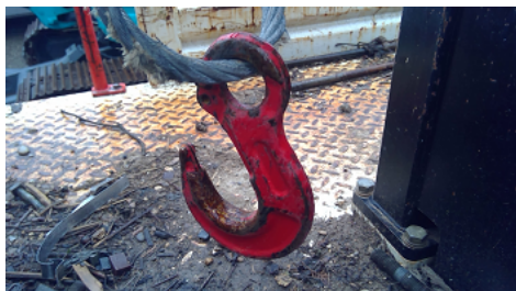
Observation 0404 : Détérioration du linguet s'opposant au décrochement accidentel des charges LINGUET MANQUANT
